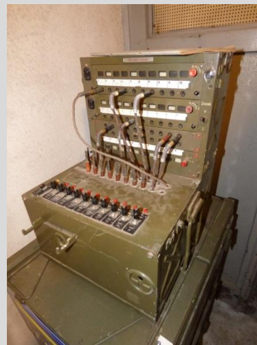
WOJSKOWY KABEL TELETECHNICZNY W ULICY POZNAŃSKIEJ
