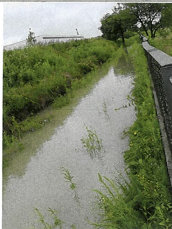
rów wzdłuż płotu Rohra
