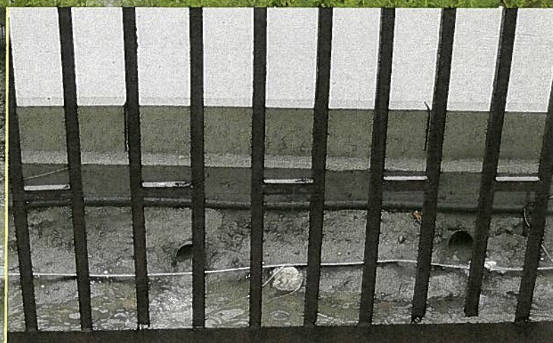
Rury przepustowe pod bramą Rohra. fot. G. Ciura
