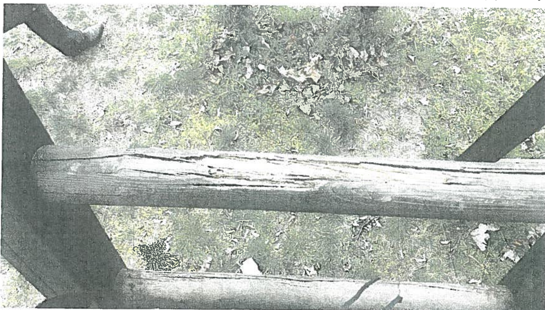
Fot. nr 4. ZESTAW ZABAWOWY: drabinka dwustronna - 6x szczelki do wymiany
