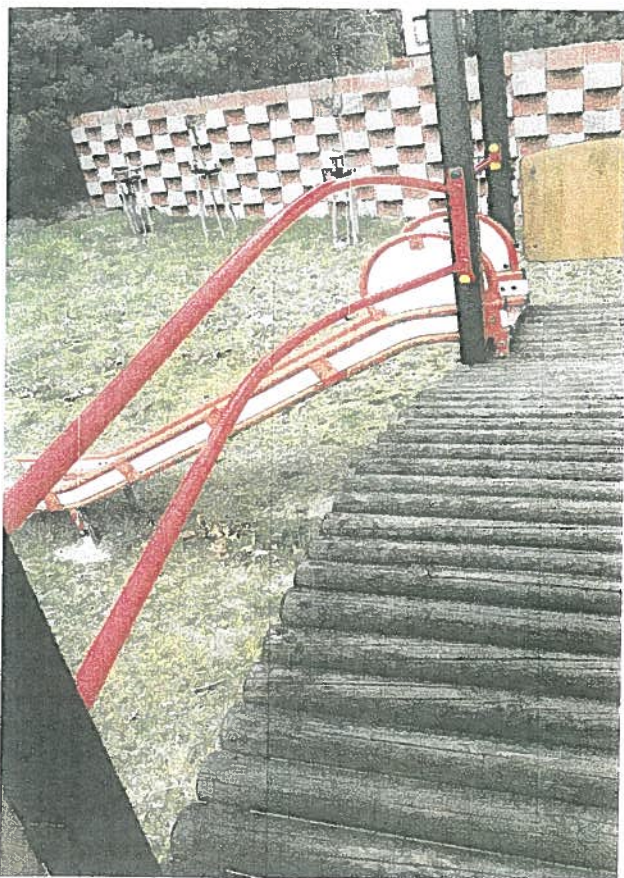
Fot. nr 2. ZESTAW ZABAWOWY: przejście łukowe - wygięte poręcze do wyprofilowania
