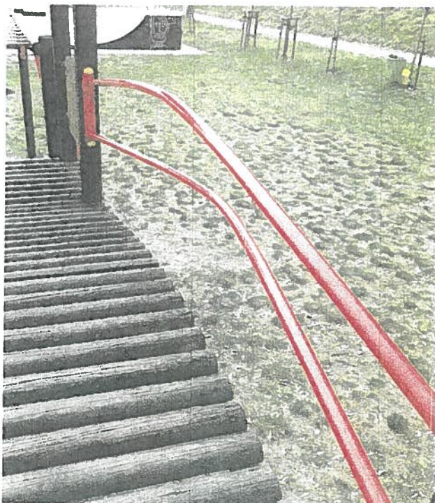
Fot. nr 1. ZESTAW ZABAWOWY: przejście łukowe - wygięte poręcze do wyprofilowania
