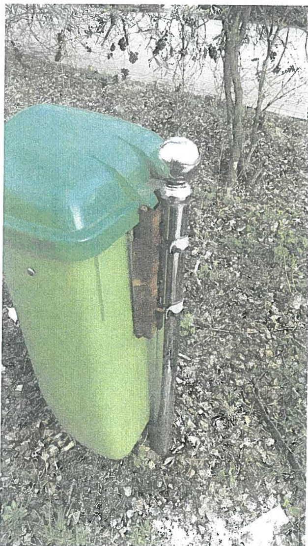
Fot. nr 10. KOSZ NA ŚMIECI PLASTIKOWY - mocowanie oczyścić z rdzy, pomalować lub wymienić na nowe
