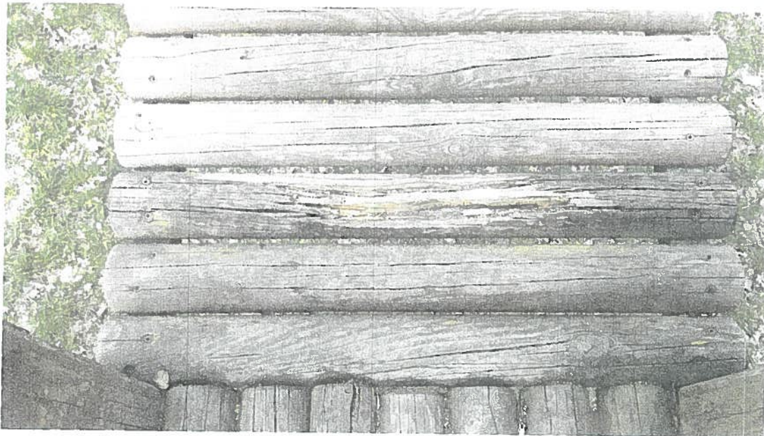
Fot. nr 1. ZESTAW ZABAWOWY: przejście łukowe - 1x belka do wymiany
