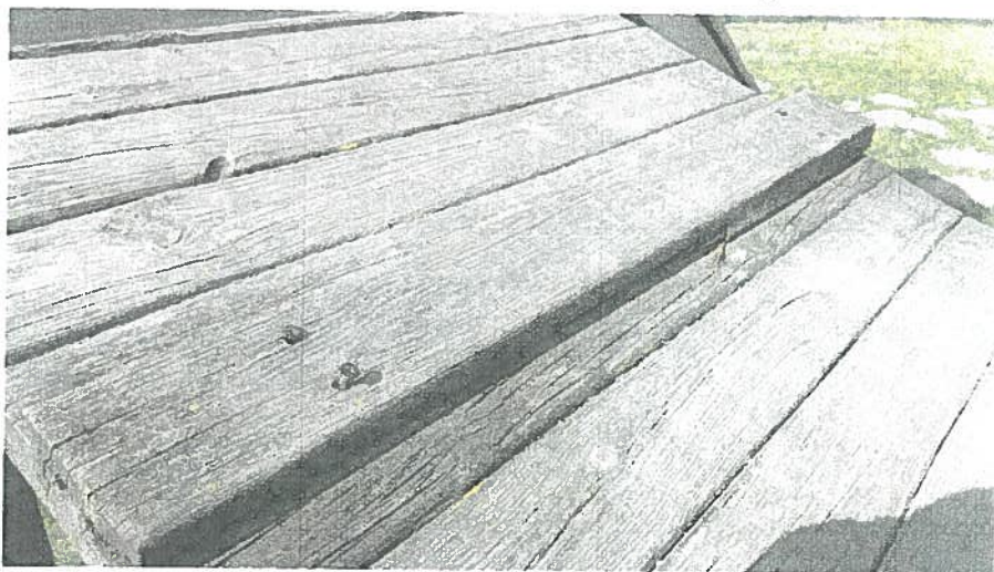
Fot. nr 2. ZESTAW ZABAWOWY: trap - belka hamulcowa do wymiany
