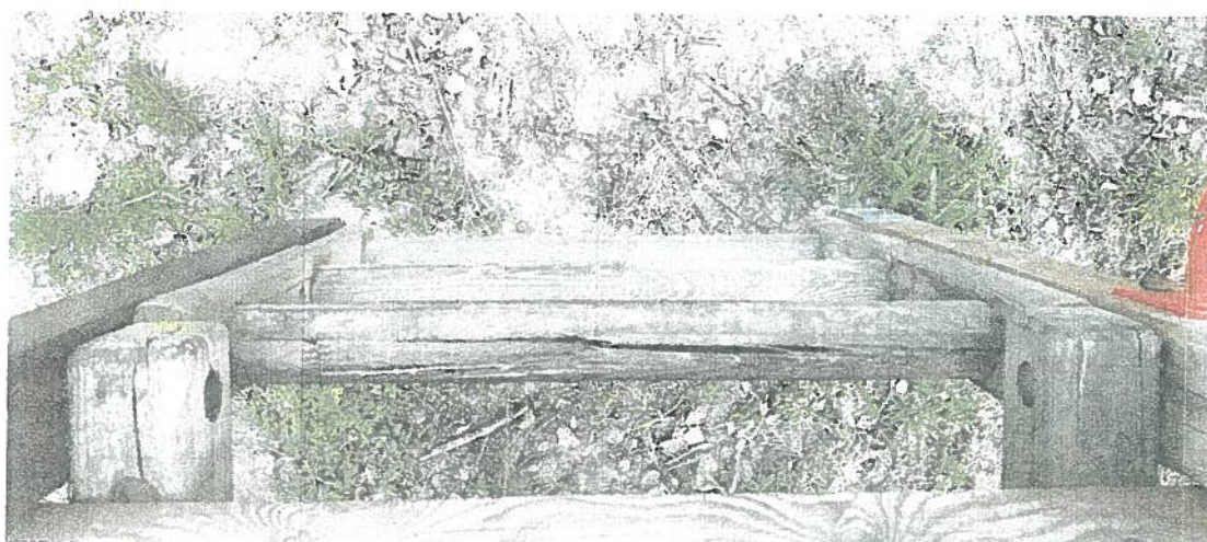
Fot. nr 5. ZESTAW ZABAWOWY: wejście po rurkach - 1x górny szczebelek do wymiany
