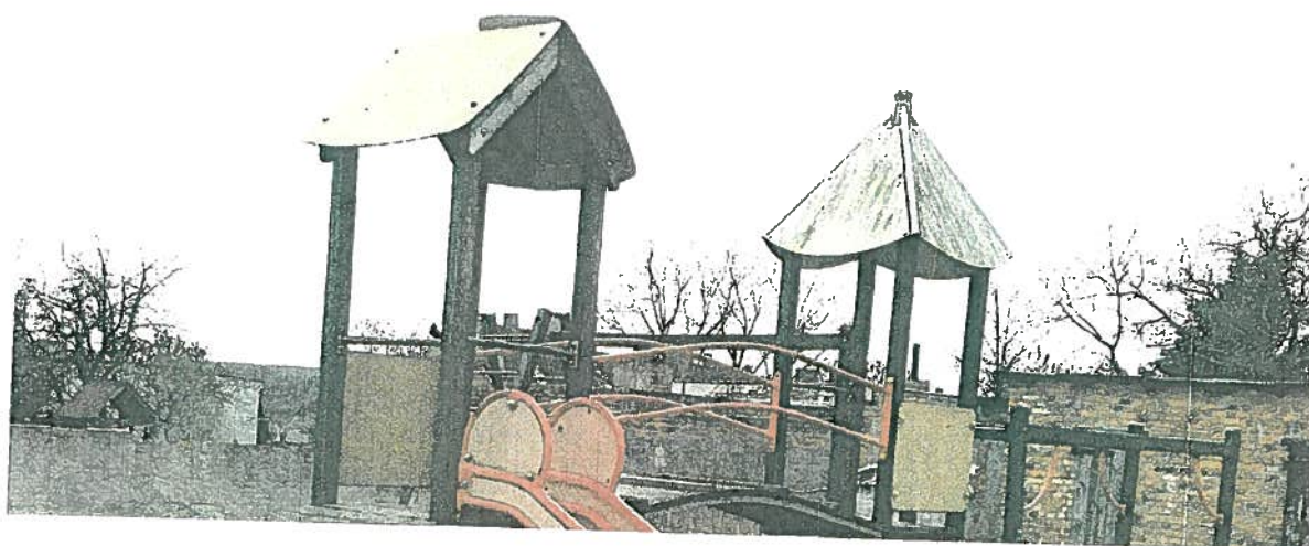
Fot. nr 1.2.3.4.5.6.7. ZESTAW ZABAWOWY: ślizg: zaślepki (8 szt.) do uzupełnienia, kratownica z lin: poprawić mocowanie liny do słupa, daszki: do wymiany.
