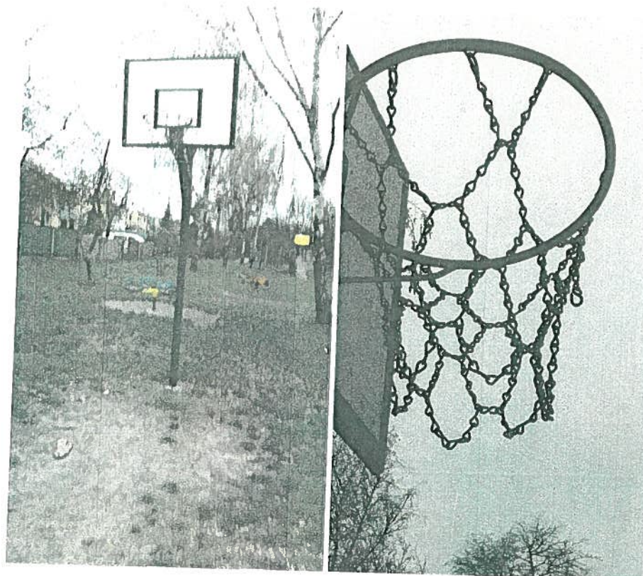
Fot. nr 7, 8. KOSZ DO KOSZYKÓWKI: brak utwardzonego placu do kozłowania piłki, poprawić mocowanie łańcucha do kosza.
