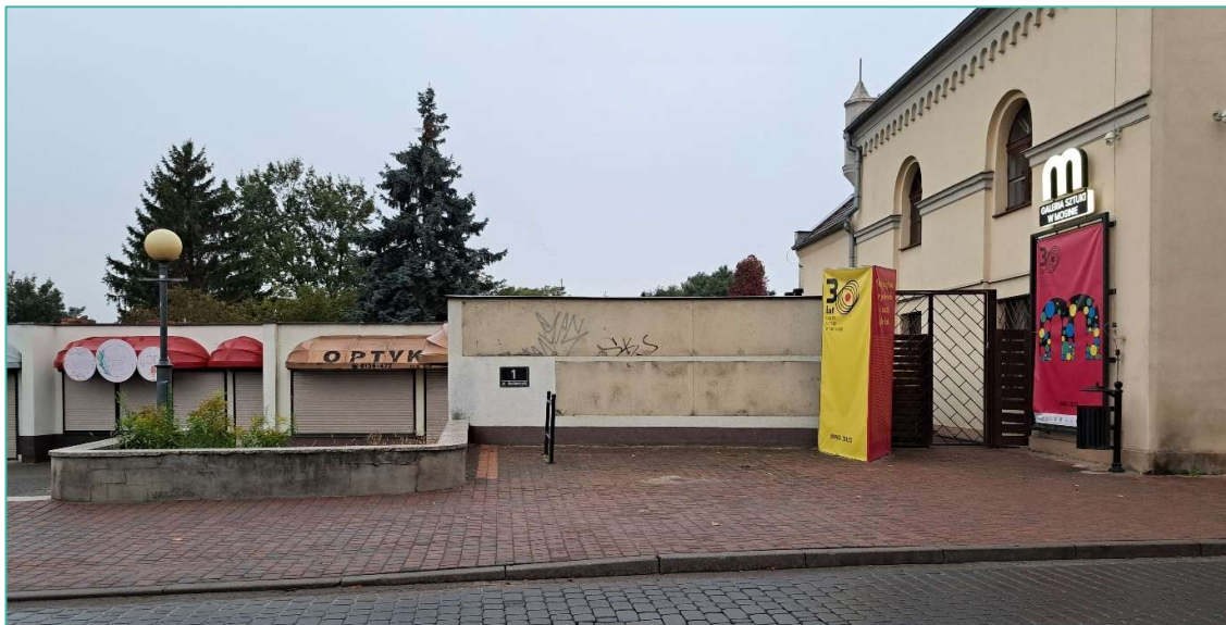
Zdj. 72 Demontaż banerów, reklam – po
