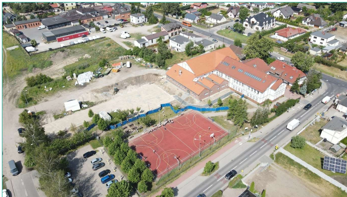
Zdj. 65 Budowa sali gimnastycznej przy SP w Krosinku
