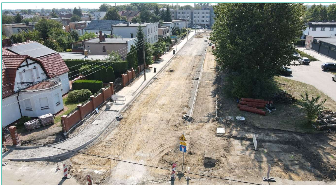
Zdj. 25 Przebudowa ul. Budzyńskiej w Mosinie
