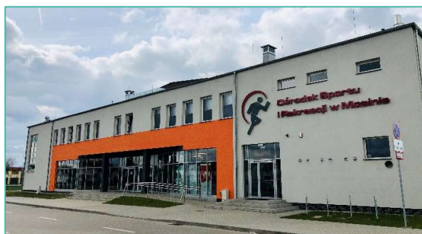
Zdj. 8 Hala sportowa Ośrodka Sportu i Rekreacji w Mosinie przy ul. Krasickiego 16
