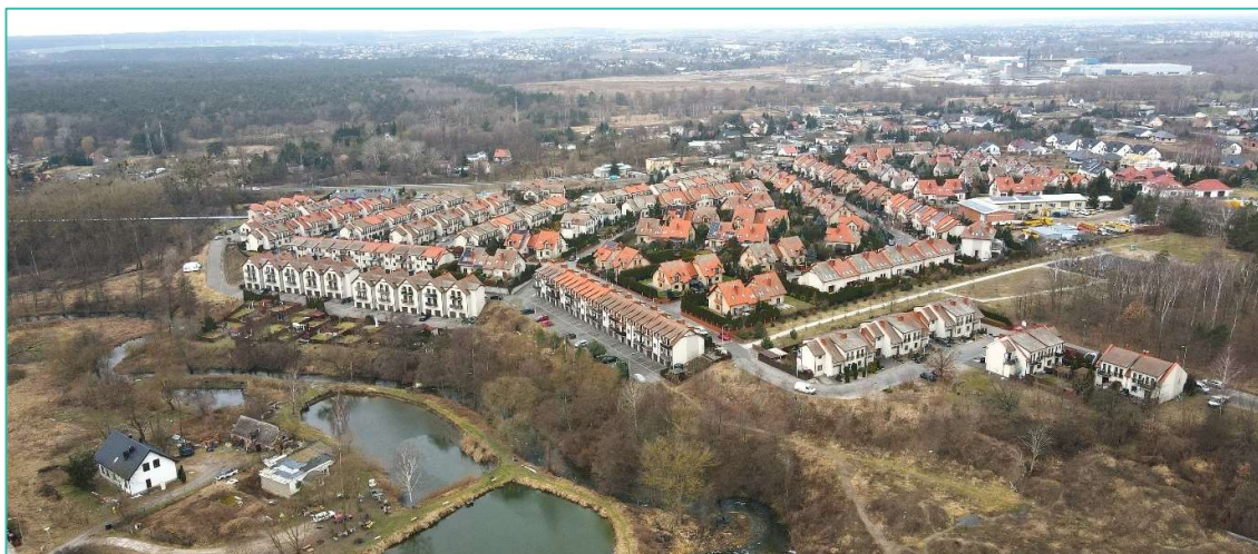
Zdj. 10 Osiedla w Czapurach
