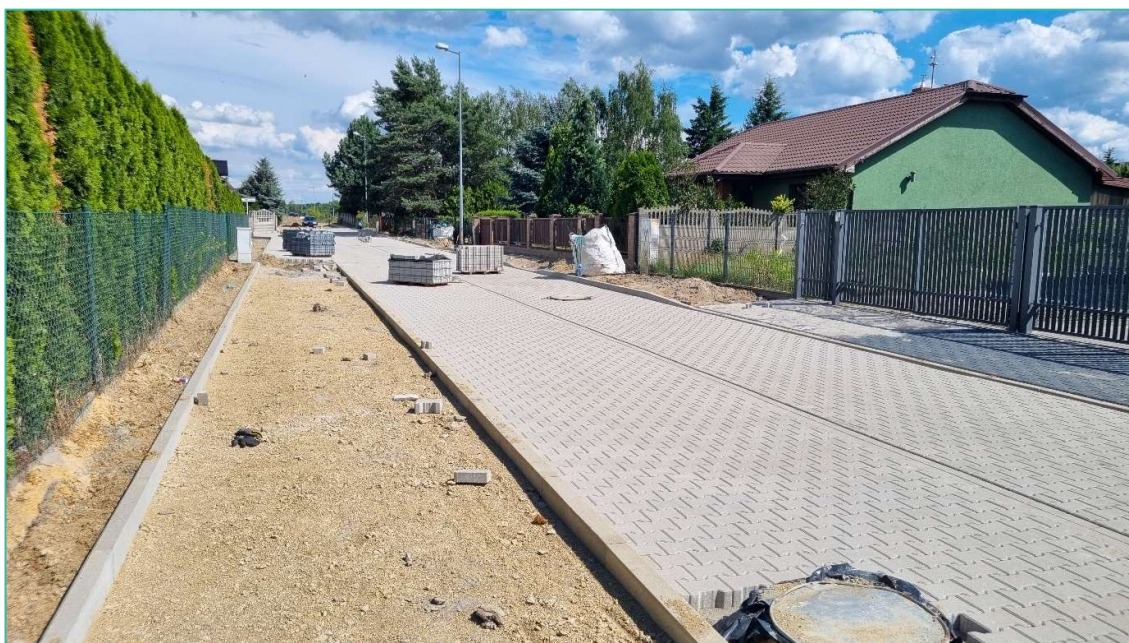
Zdj. 24 Budowa ul. Mieszka I w Mosinie
