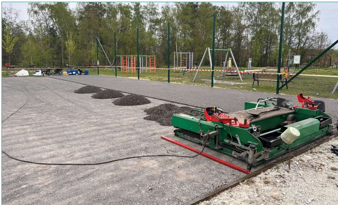
Zdj. 55 Budowa nowego boiska w Czapurach
