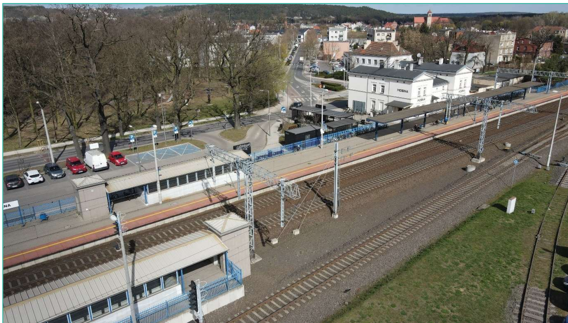
Zdj. 29 Dworzec kolejowy w Mosinie
